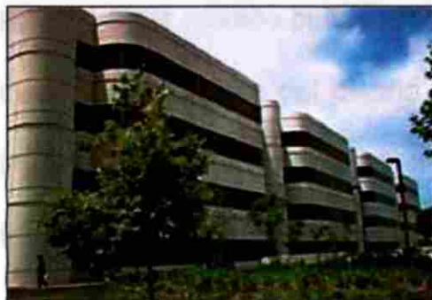
Fig. 3.15 Foothill Communities Law and Justice Center (Primer edificio con aislamiento de base)
