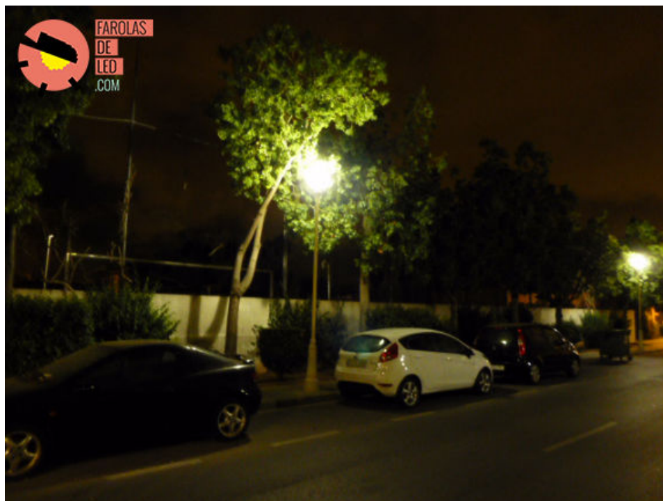
Figura 1.3: Iluminación LED en Almàssera, Valencia. Imagen tomada de [1].
