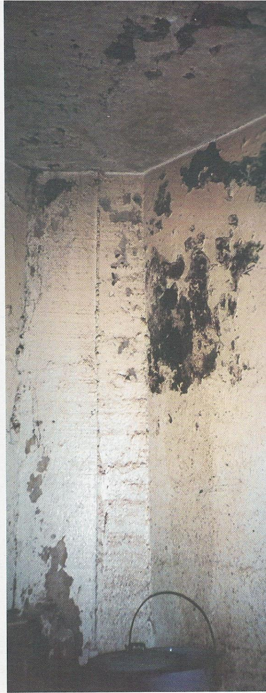
Estado general de pintura en muros
