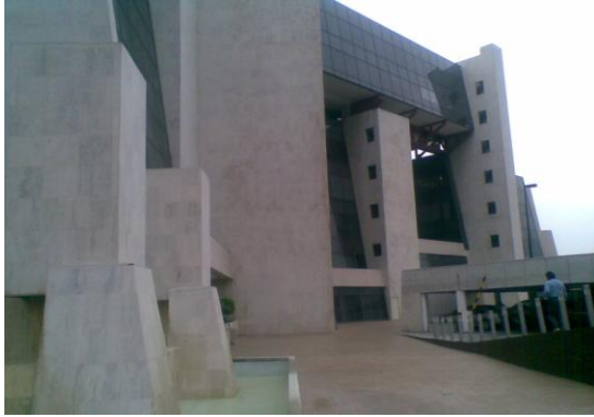
Fotografía 1: Edificio Los Soles
