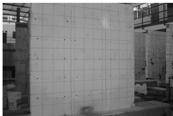
Fig. 4. Agrietamiento vertical en muro de paneles de concreto con PET después del ensaye a compresión.
