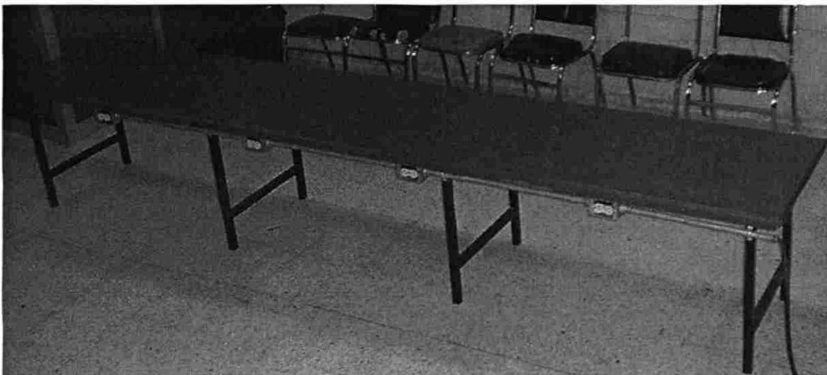
En las imágenes siguientes se muestra la instalación eléctrica, la cual es montada en las mesas a diferencia de las tradicionales, esto con el fin de evitar la instalación sobre el piso, lo cual ayuda para su protección contra la humedad, además esto nos dará la facilidad de trasportarla a alguna exhibición en caso de ser necesario.
