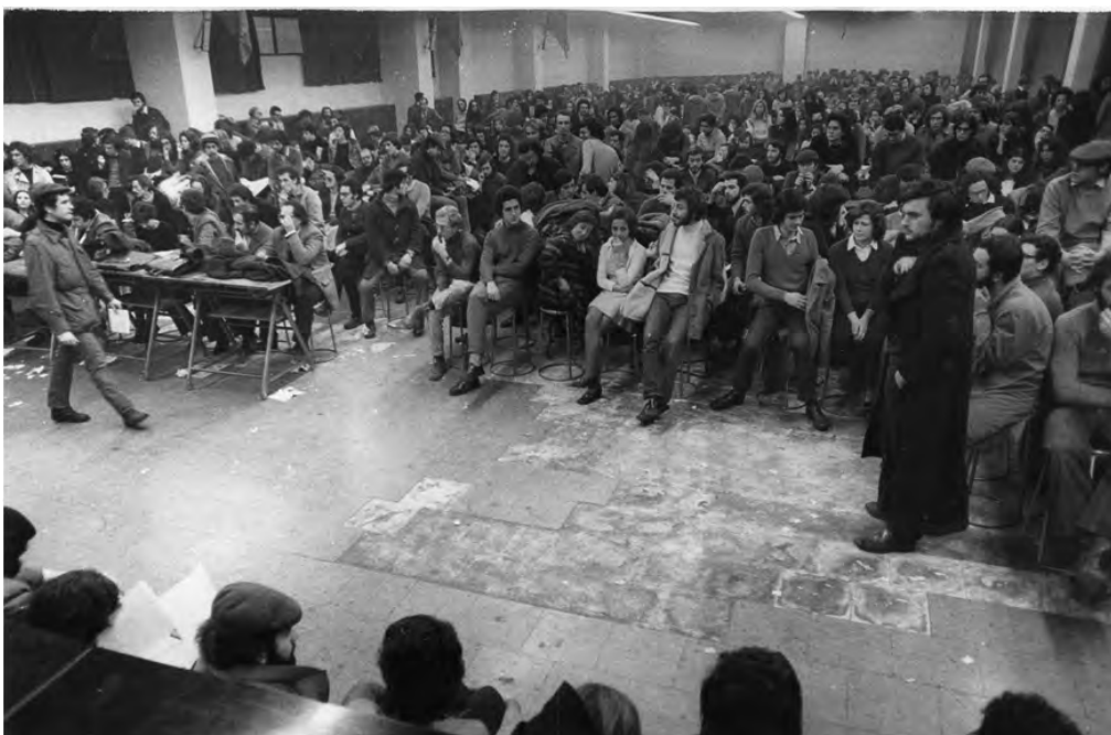
Aula IV, Facoltà di architettura del Politecnico di Milano, primi anni settanta
