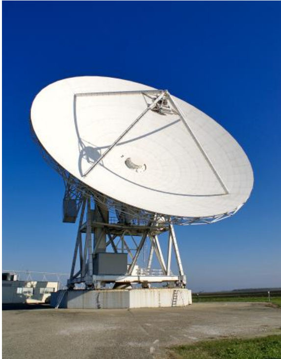
Figura 35 Antenna parabolica da 32 metri di diametro, del radiotelescopio dell'Istituto Nazionale di Astrofisica, situato a Medicina (BO) 2 .
