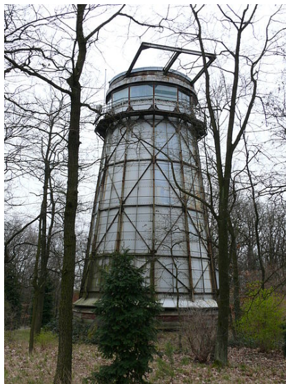
Figura 1.11: Torre di Helmert a Potsdam.
