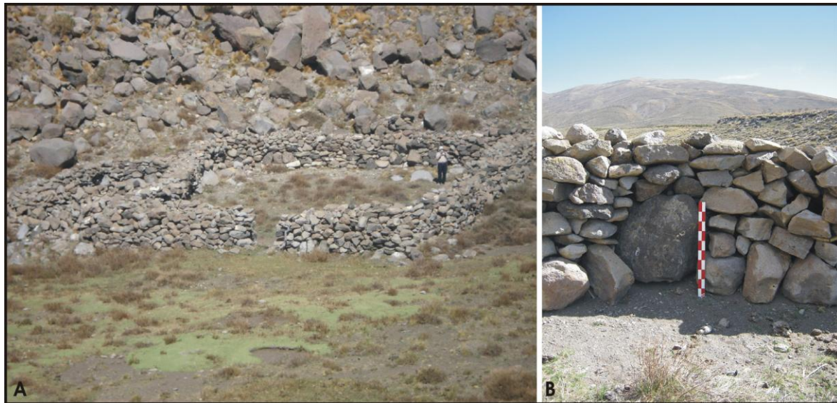
Figura 7.24. Puesto Basualdo 2. A: imagen panorámica. B: detalle del muro. Nótese el aprovechamiento de los grandes bloques de piedra que se encuentran en el área
