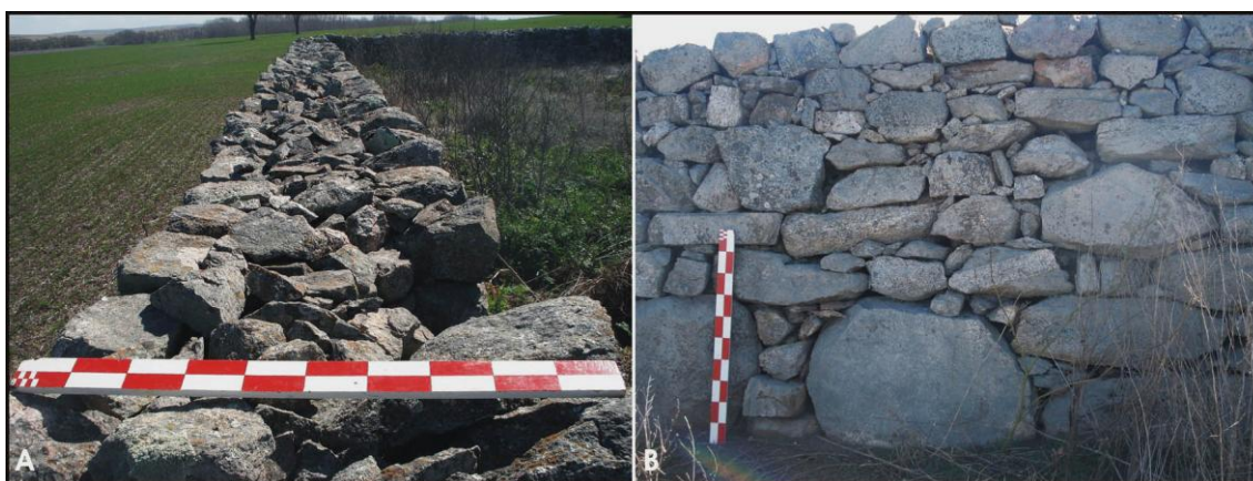
Figura 6.24. Los Bosques. A: detalle del doble muro. B: utilización de rocas de diferentes tamaños en la construcción de la pirca
