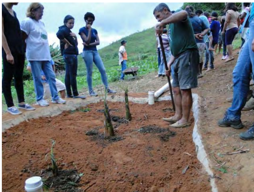
FIGURA 2. Participantes do mutirão finalizando a montagem da fossa evapotranspiradora.
