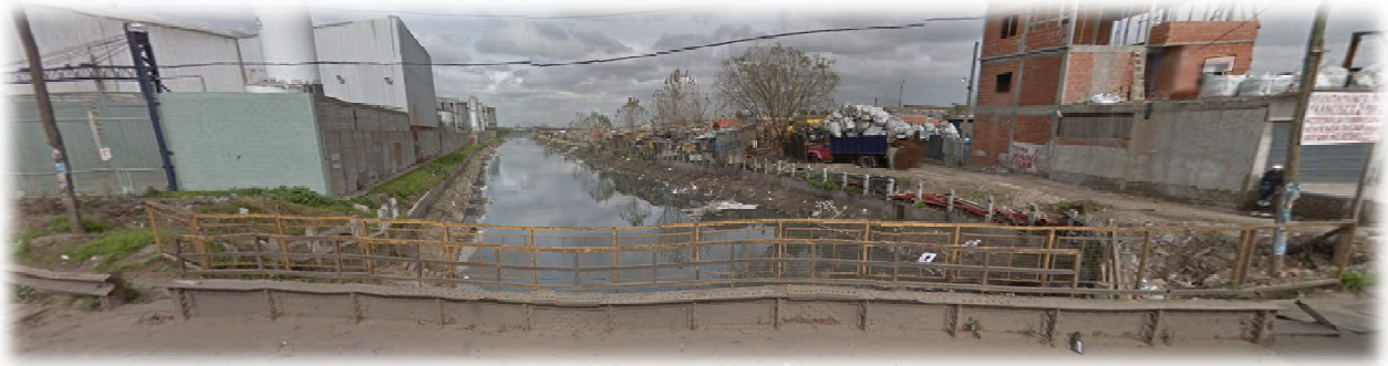
Figura 3.10: Sitio de monitoreo LP4. Sobre el margen izquierdo se observa una importante grasería y sobre el derecho, un asentamiento denominado “villa de los paraguayos”.
