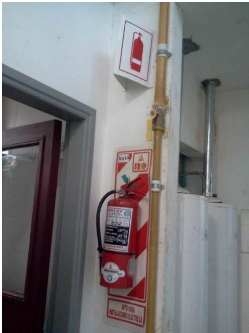
Foto 10 Algunos matafuegos están bien indicados y cumplen con los requerimientos (base rayada blanca y roja indicando usos del matafuegos y cartel indicador en parte superior), otros, Foto 11, no están colocados correctamente
