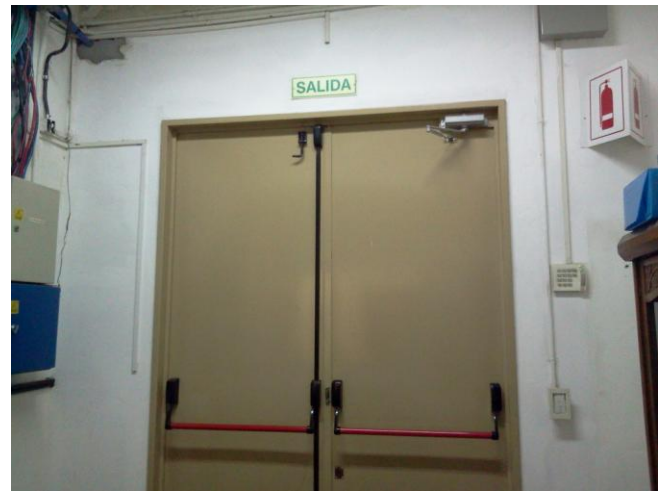
Foto 5 y 6: Rampa para discapacitados en la salida del edificio y salida con barra antipática e indicador de luz verde fluorescente en la parte superior.
