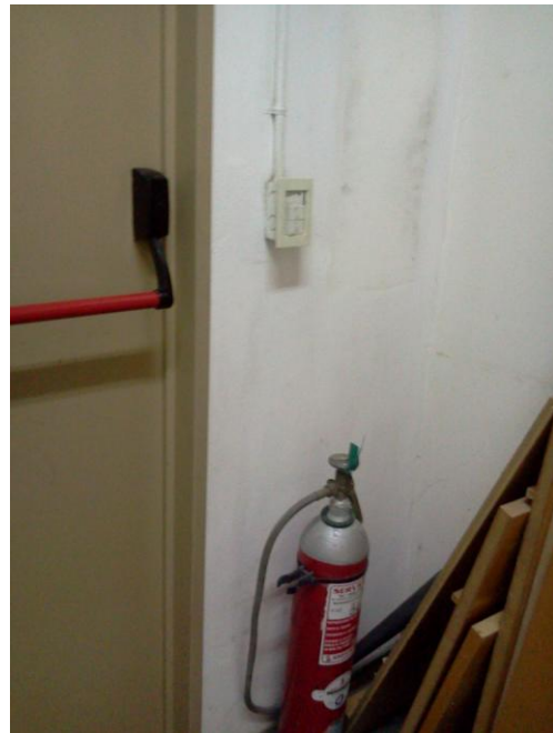
Foto 10 Algunos matafuegos están bien indicados y cumplen con los requerimientos (base rayada blanca y roja indicando usos del matafuegos y cartel indicador en parte superior), otros, Foto 11, no están colocados correctamente
