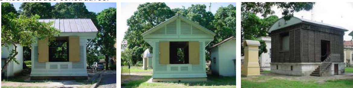
Fig. 1, 2 e 3: Pavilhão da Luneta Meridiana Zenital; Pavilhão da Luneta Meridiana Askania e Pavilhão da Luneta Meridiana Bamberg (respectivamente). Fonte: http://www.mast.br/acervos_arquitetonico_museologia.html
