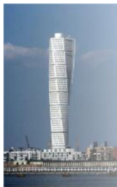
Fig. 10 – Vista del edificio
