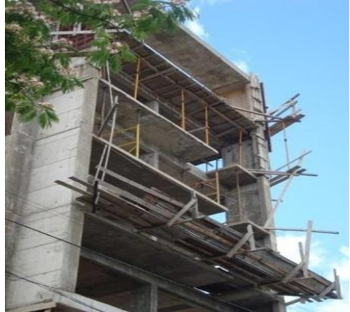
Fig. 6: Bandejas móvil sobre la vía pública. PH1
