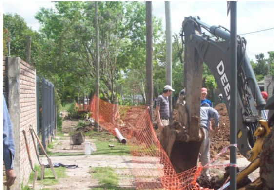
Fig. 3 Obras y ocupación en la vía pública. OI
