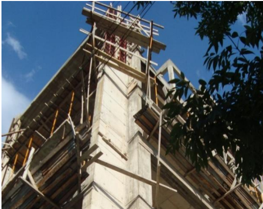
Fig. 7: Bandejas de protección en 4° y 6° nivel. PH1
