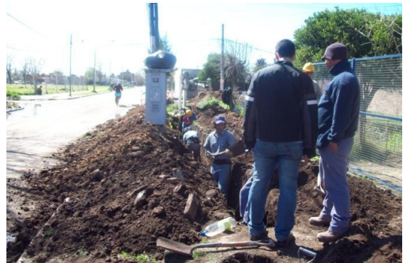
Fig. 10: Talud de excavación. OI
