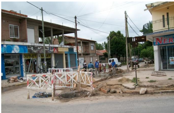
Fig. 9: Trabajos en la vía pública. OI
