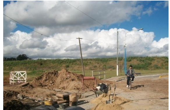
Fig. 14: Acopio de materiales. OI
