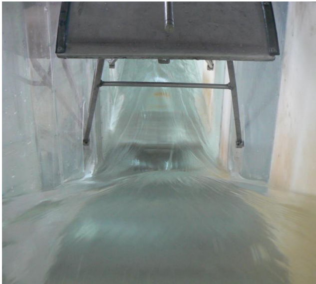
Figura 6.- Descarga del vertedero modificado
