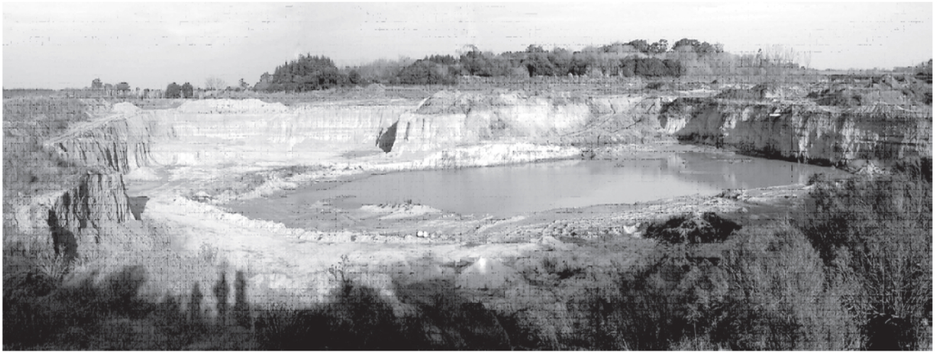
Cantera abandonada, con afloramiento de nivel freático.
