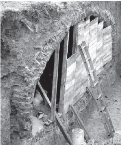
Calle 14 y 40. Antiguo conducto pluvial, hoy desactivado por uno de mayor sección.
