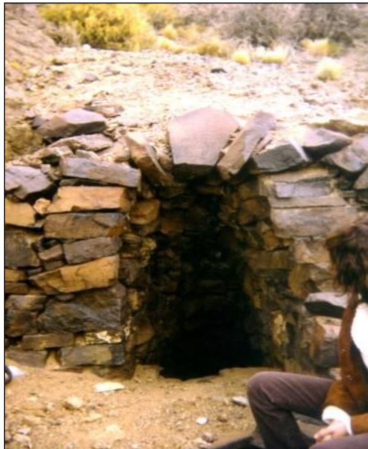
Figura 8.8. Entrada a la mina Descubridora de la veta Vallejos; tanto la entrada como el socavón de acceso a la mineralización están realizados en piedra por los antiguos mineros ( Molina 1788 ).
