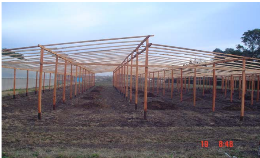
Foto 6: Invernadero tipo capilla con abertura cenital
