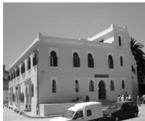
Centro de la Mujer en Tánger (Marruecos), construido con el apoyo de CIDEAL y AEI.
