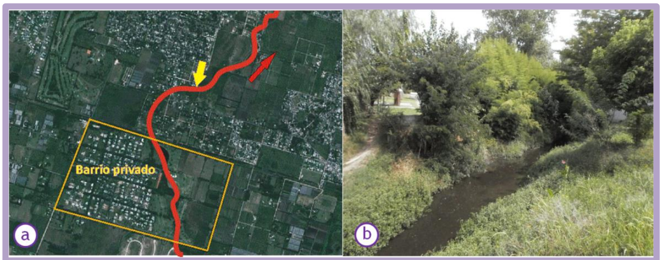
Fig. 5.5 a) Foto satelital de parte del sector medio del arroyo Rodríguez; se indican el punto en donde se realizó la experiencia (aguas abajo del barrio privado, flecha amarilla) y la dirección del flujo (flecha roja). b) Aspecto general del tramo en donde se llevó a cabo el experimento.
