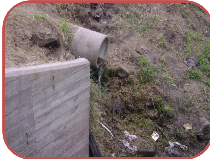
Fig. 3.19. Vertido domiciliario sin tratamiento previo hacia el arroyo Martín.
