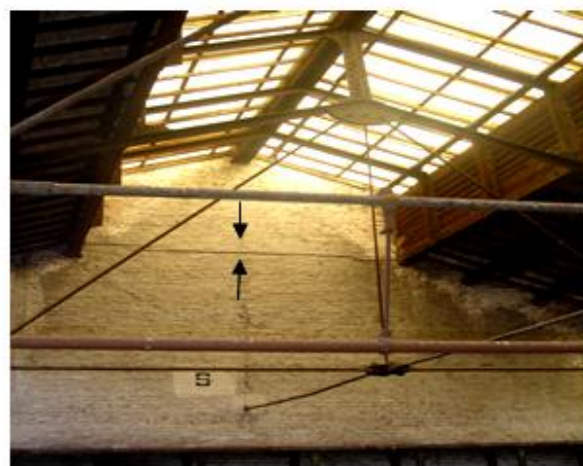
Figura 3: Fisuras horizontales en la parte inferior (izquierda) y superior (derecha) en un muro transversal.
