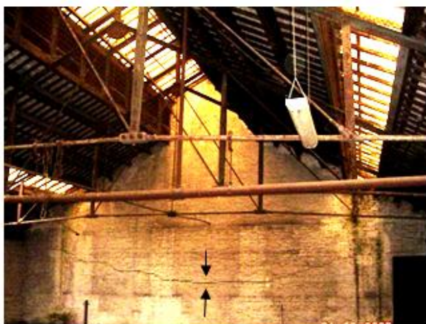
Figura 3: Fisuras horizontales en la parte inferior (izquierda) y superior (derecha) en un muro transversal.
