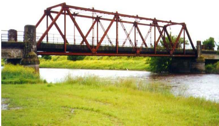
Fig. 5. Vista general del puente sobre canal 9.
