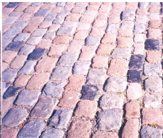
Fig. 8. Detalle del empedrado.
