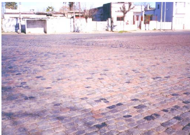
Fig. 7. Calle con adoquines.
