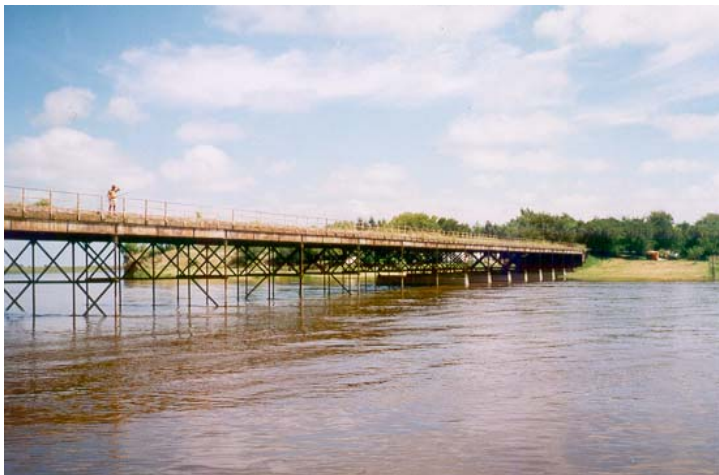
Fig. 3. Vista general del puente La Postrera.
