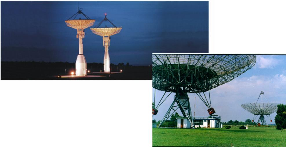
Figura 4.1 - Antenas reflectoras parabólicas de revolución, a) estación terrena de observaciones de satélites de orbita baja (LEO) y b) antenas de observación radioastronómicas.
