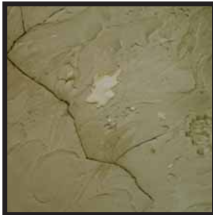
(d) segment of paint loss
