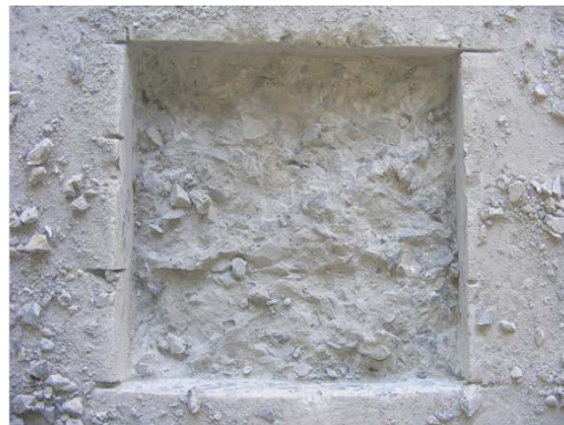
(d) Cut and chipped patch area
