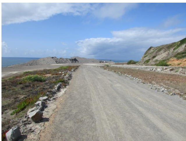
Figura 34 - Percurso em frente à Pedreira Sul
