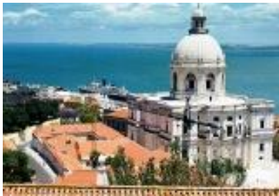
Figura 44 – Igreja de S. Vicente de Fora – Zona protegida, no exterior, nascente, (MARQUES 2014).
