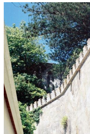
Figura 42 – Igreja de Santa Maria – vista nascente, (MARQUES 2014).
