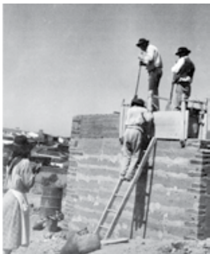
Figura 14 - Execução de parede em taipa [14]
