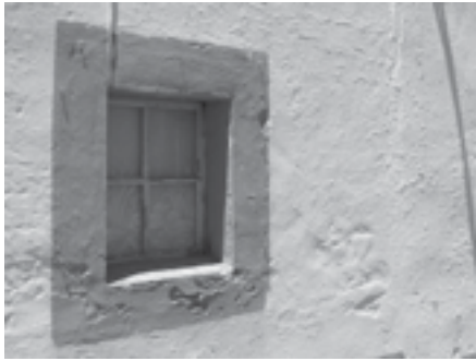
Fig. 6 - Évora. Sombreamento de vão, orientado para sul, no solstício de verão ao meio dia solar [15]
