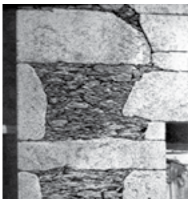
Figura 10 - Pormenor de alvenaria de pedra, Olela [14]
