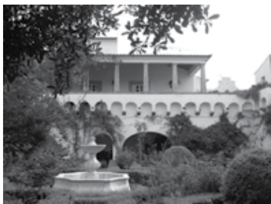
Fig. 8 - Pátio em habitação de Évora [15]
