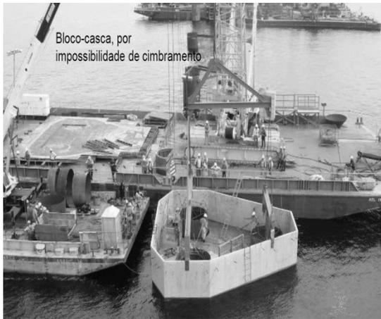
*Figura 6.12* Detalhes executivos das estacas e blocos de fundação (Domingues, 2009).
