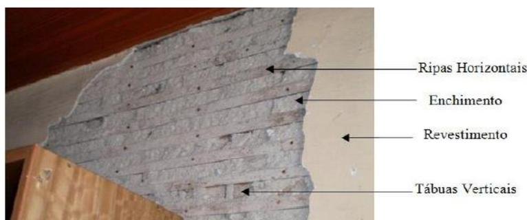
Figura 2: Parede interior de tabique de um edifício de habitação unifamiliar [4]
