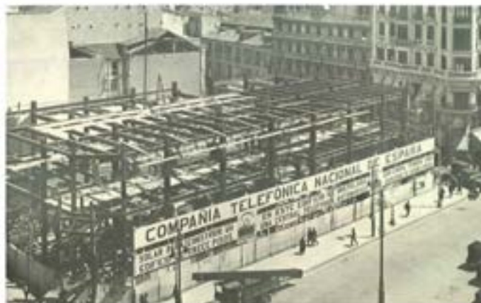
Elevación de los primeros pilares de estructura.
