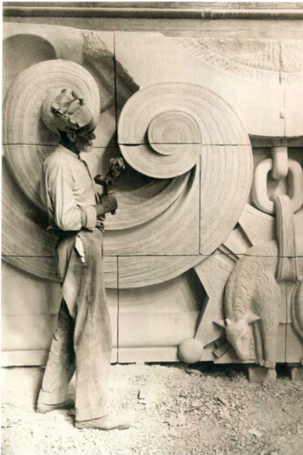
Figura 139. Fuente: Fundación Telefónica (2005). Detalle de esculpido del escudo central de la fachada, situado en la torre de coronación.
