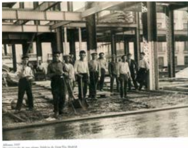
Figura 138. Fuente: Fundación Telefónica (2005). Hormigonado de una planta del edificio telefónico.
