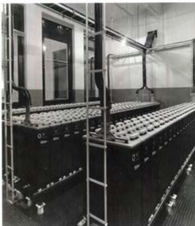
Figura 143. Fuente: Fundación Telefónica (2005). Espacios de la central consistente en: grupo electrógeno, sala de baterías, e instalaciones de aire acondicionado y ventilación situados generalmente en las plantas sótano de los edificios telefónicos. Situación: Edificio de la Telefónica de Gran Vía de Madrid
