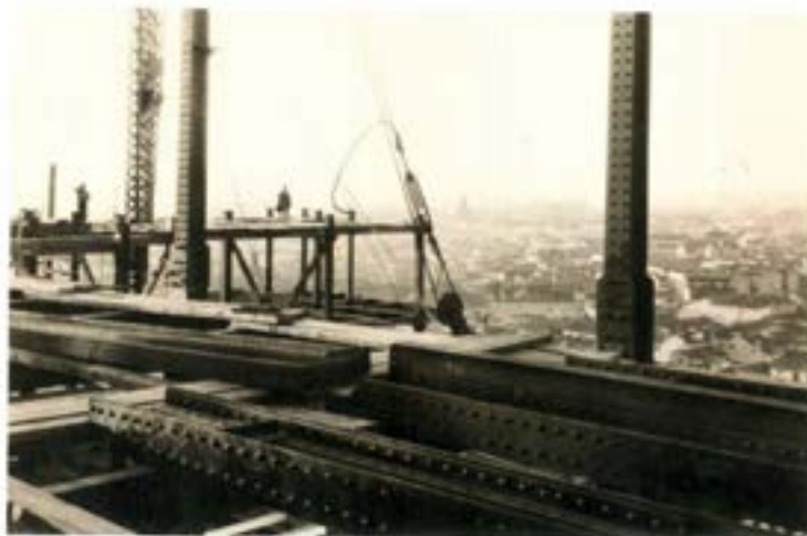
Figura 29. Fuente: Fundación Telefónica (2005). Véase los detalles de los pilares de perfiles compuestos roblonados de nuestro rascacielos.
