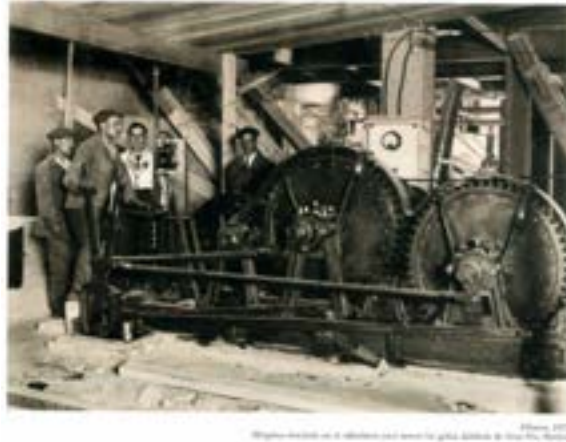
Figura 33. Fuente: Fundación Telefónica (2005). Sistema mecánico colocado en el subsótano para mover las grúas de las obras de Gran Vía.
