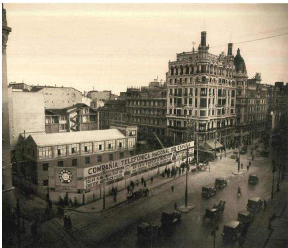
Figura 156. Fuente: Fuente: Fundación Telefónica (2005). Véase la central telefónica provisional al fondo del solar.
