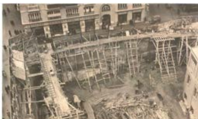
Vista general de la excavación, con la estructura de acero y construcción de tierra y grava para iniciar de trabajo.
