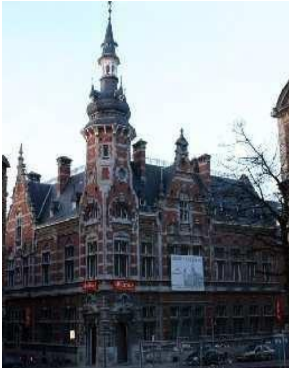
Figura 81: Izquierda, edificio postal y telefónico de Lovaina (Bélgica), 1893-1895, Alfons van Houcke. Fuente: ArcheoNet Vlaanderen . Derecha, central telefónica, Gante (Bélgica), 1902, Alfons Van Houcke. La torre de 57 m. servía de acometida para el cableado. En Lovaina hay una torre análoga.
