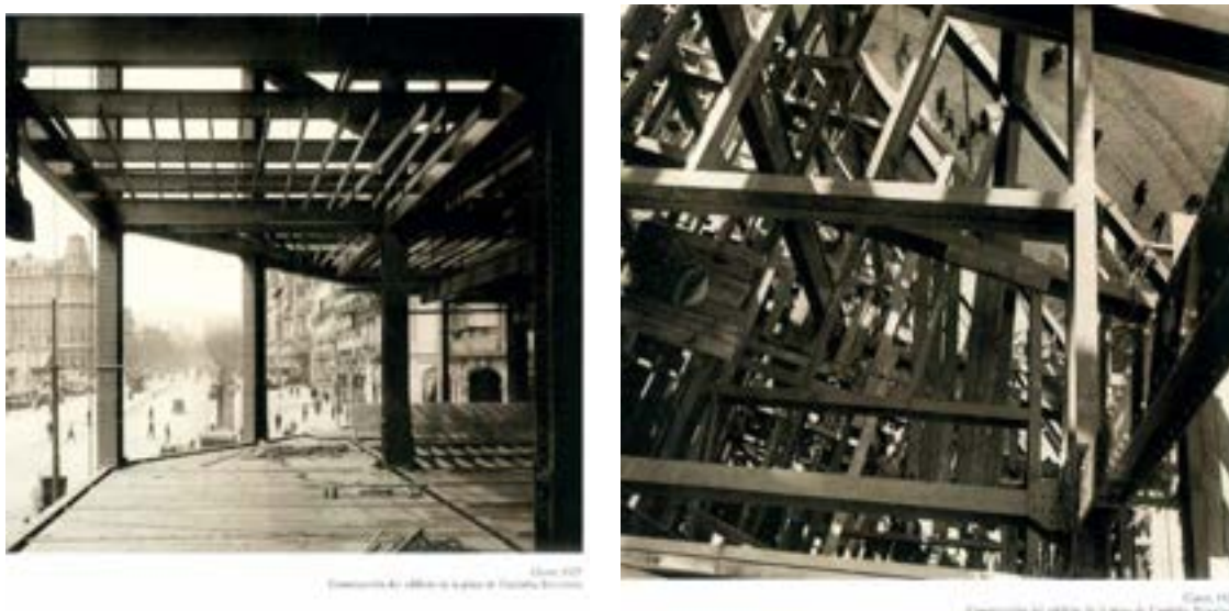
Figura 31. Fuente: Fundación Telefónica (2005). Véase el entramado metálico de la estructura con sus nudos de unión.
