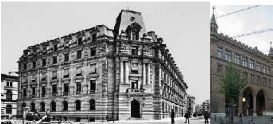
Figura 82: Izquierda. Edificio de la administración postal en la Speigergasse de Berna (Suiza), que servía también de central telefónica manual. Esta fotografía es de 1904. Era también sede de la Oficina de Patentes y aquí trabajaba Albert Einstein cuando en 1905 publicó su Teoría de la Relatividad Especial. Fuente: Instituto Federal de la Propiedad Intelectual de Suiza . A la derecha, oficina de la PTT en Basilea, de principios del siglo XX, una recreación del estilo medieval de la ciudad.
