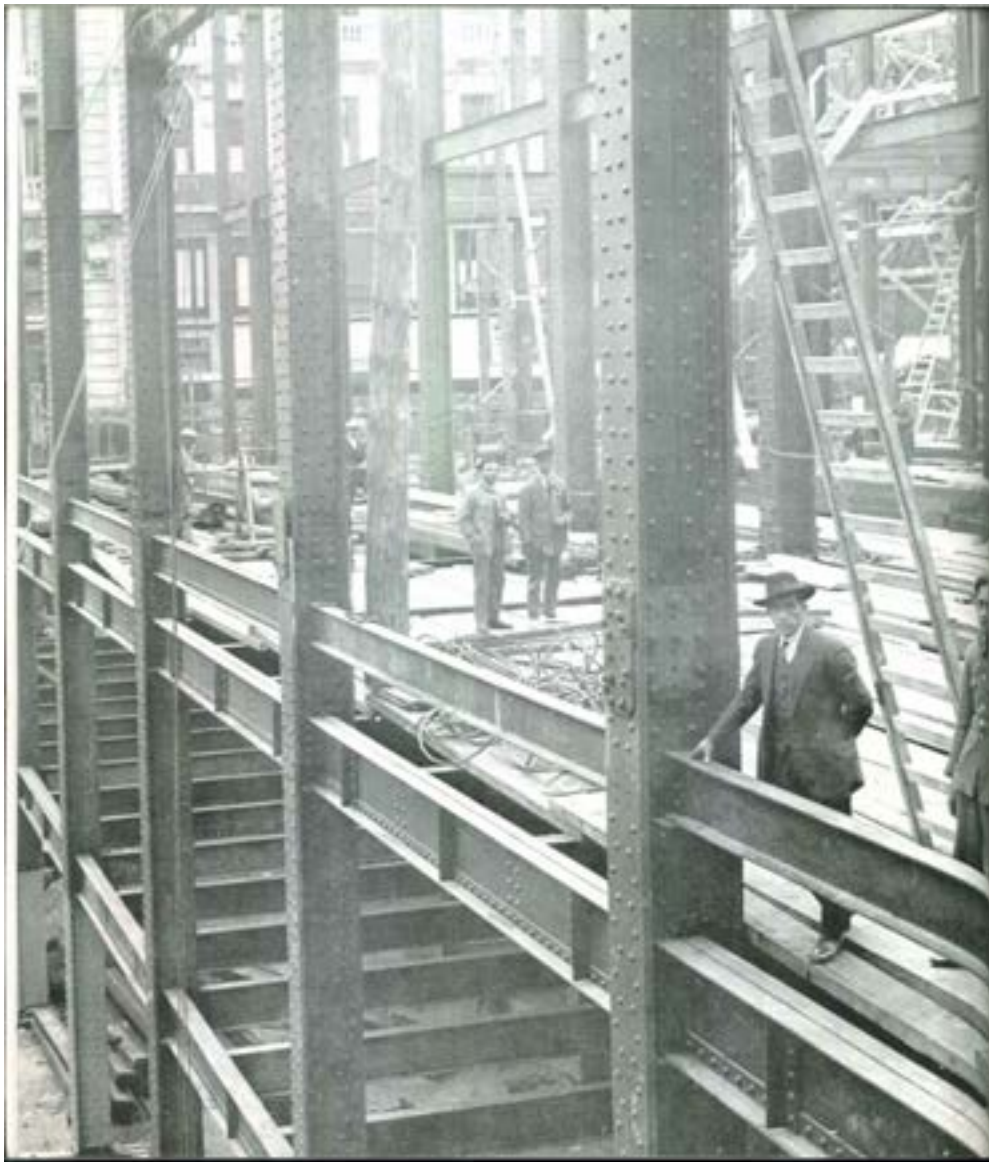
Figura 134. Fuente: Fundación Telefónica (2005). Foto de época con la imagen del esqueleto metálico y sus detalles de ensamblado, con la imagen del arquitecto director posando junto a un pilar. Aquí se puede apreciar los elementos y detalles de la estructura, sus perfiles, acartelados, Rigidizadores, nudos de encuentro, entrevigados, etc.
