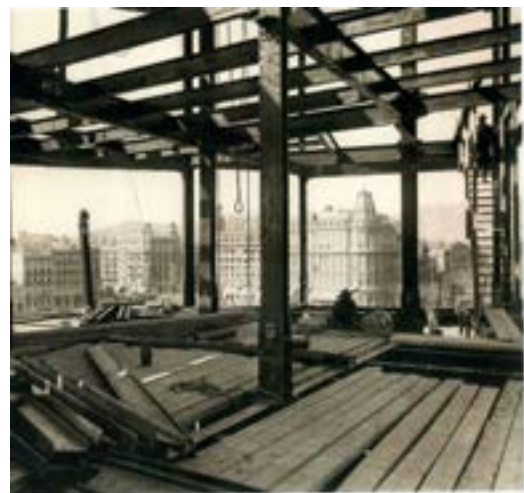
Figura 30. Fuente: Fundación Telefónica (2005). Los pilares metálicos empleados en el edificio de Telefónica tenían una longitud de dos plantas, facilitando el montaje.
