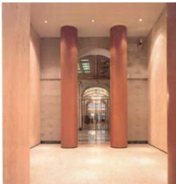
Figura 171. Fuente: Rehabilitación del Edificio de la telefónica en la Gran Vía de Madrid, Dragados (1992). Zona de unión de lo antiguo con la reforma de 1992.
