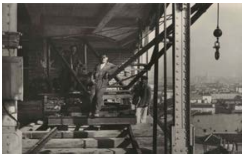
Figura 136: Detalles del proceso de elevación de la estructura. Fuente: Fundación Telefónica
