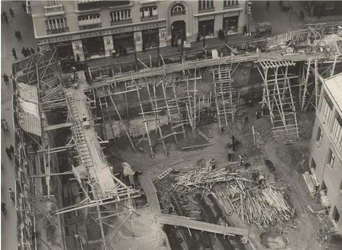
Figura 128. Vista superior del vaciado del solar y muro de contención. Fuente: Fundación Telefónica
