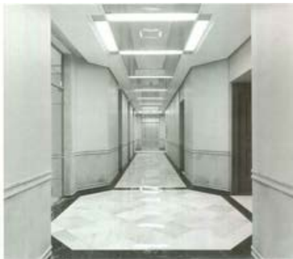
Figura 168. Fuente: Rehabilitación del Edificio de la Telefónica en la Gran Vía de Madrid, Dragados (1992.) Pasillo reformado de la zona de oficinas
