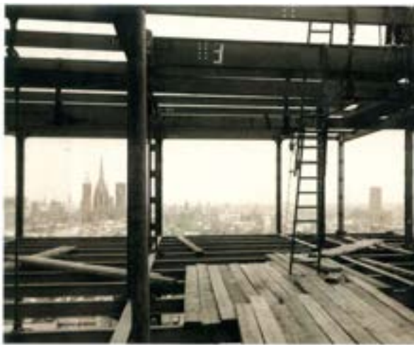
Figura 30. Fuente: Fundación Telefónica (2005). Los pilares metálicos empleados en el edificio de Telefónica tenían una longitud de dos plantas, facilitando el montaje.
