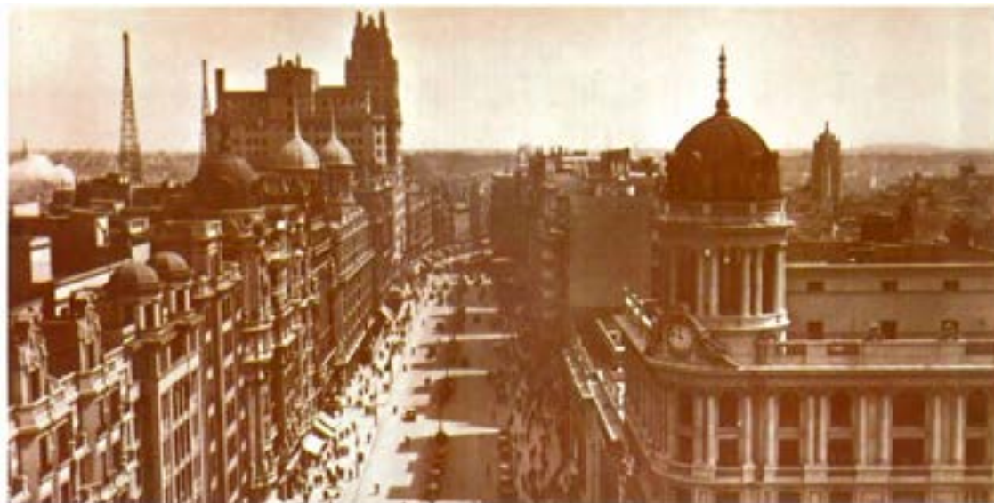
Vista de la Avenida en los años de la posguerra. Al fondo, a la izquierda, el edificio de la Telefónica
