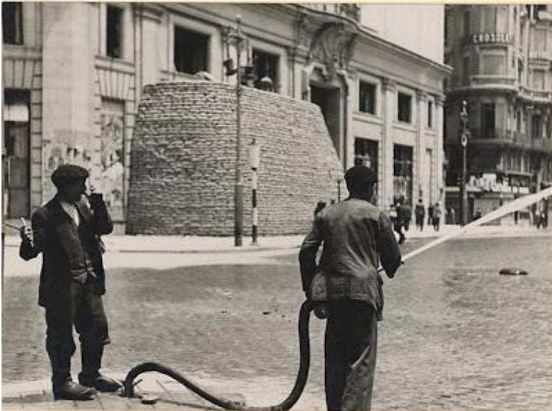
Figura 163. Protecciones con sacos terreros del edificio. Fuente: Fundación Telefónica (2004).
