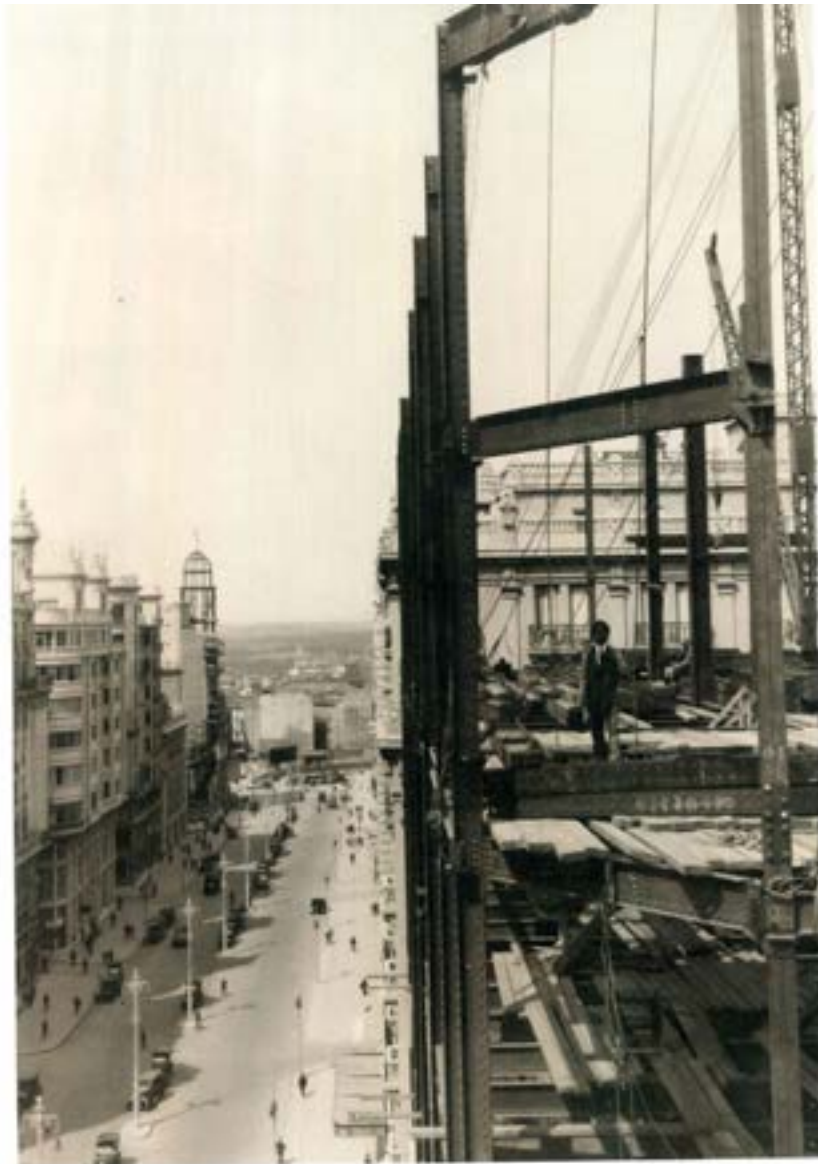
Figura 133. Fuente: Fundación Telefónica (2005). Montaje de estructura metálica. Véase el arriostamiento provisional mediante cables metálicos.
