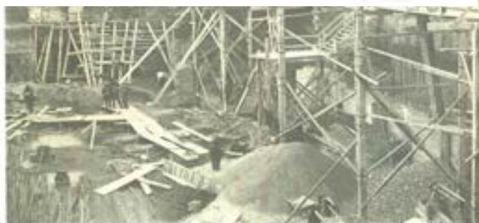
Filero de sacos Uliga y hierro para los esqueletos de construcción.
