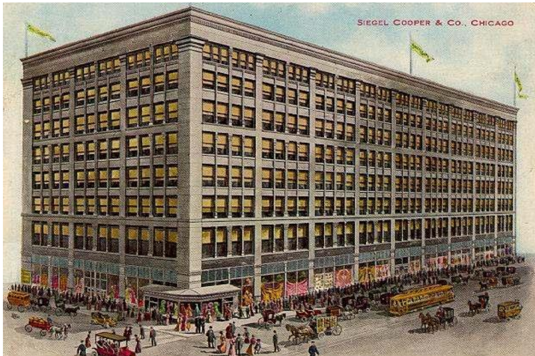
Figura 23: Imagen de la época del Second Leiter Building de 1889-90. Fuente: buildingchicago.wordpress.com
