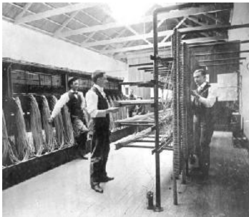
Figura 73: imagen interior de un repartidor en una central de principios del siglo XX. Fotografía de autor desconocido.
