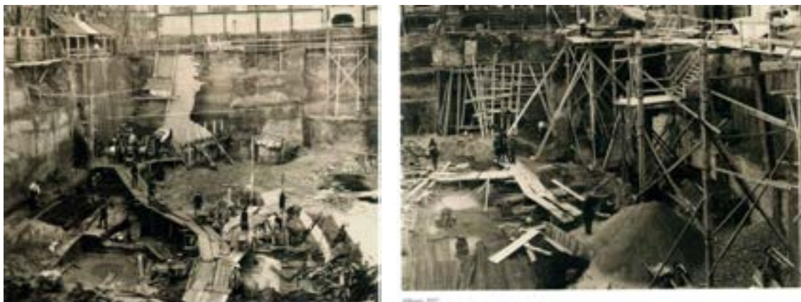
Figura 27. Fuente: Fundación Telefónica (1994). Ejecución de sótanos y cimentación en Gran Vía 28 de Madrid.
