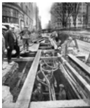
Figura 72: Izquierda, Instalación de cables subterráneos en Montreal, 1930. Fotografía: Miller Studio, Museo McCord.
