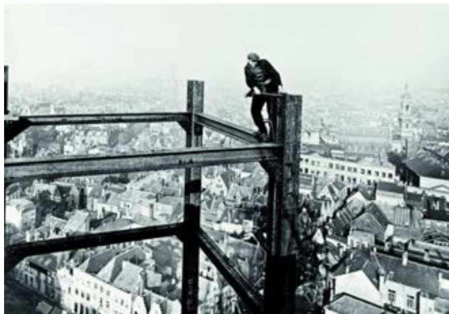
Figura 141. Fuente: Fundación Telefónica (2005). Instantáneas de los diversos tajos de la obra del rascacielos madrileño. Como puede apreciarse contaba con un taller propio de cantería.
