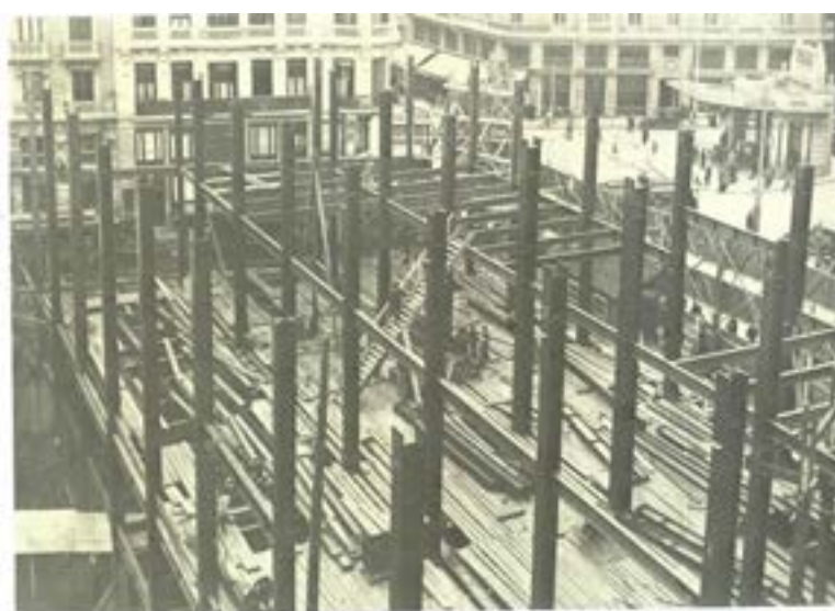
Mayo de 1927: Estructura del vestíbulo principal.
