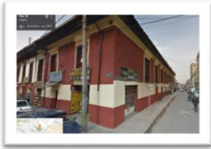
Figura 9 Bien de interés cultural demolido,
