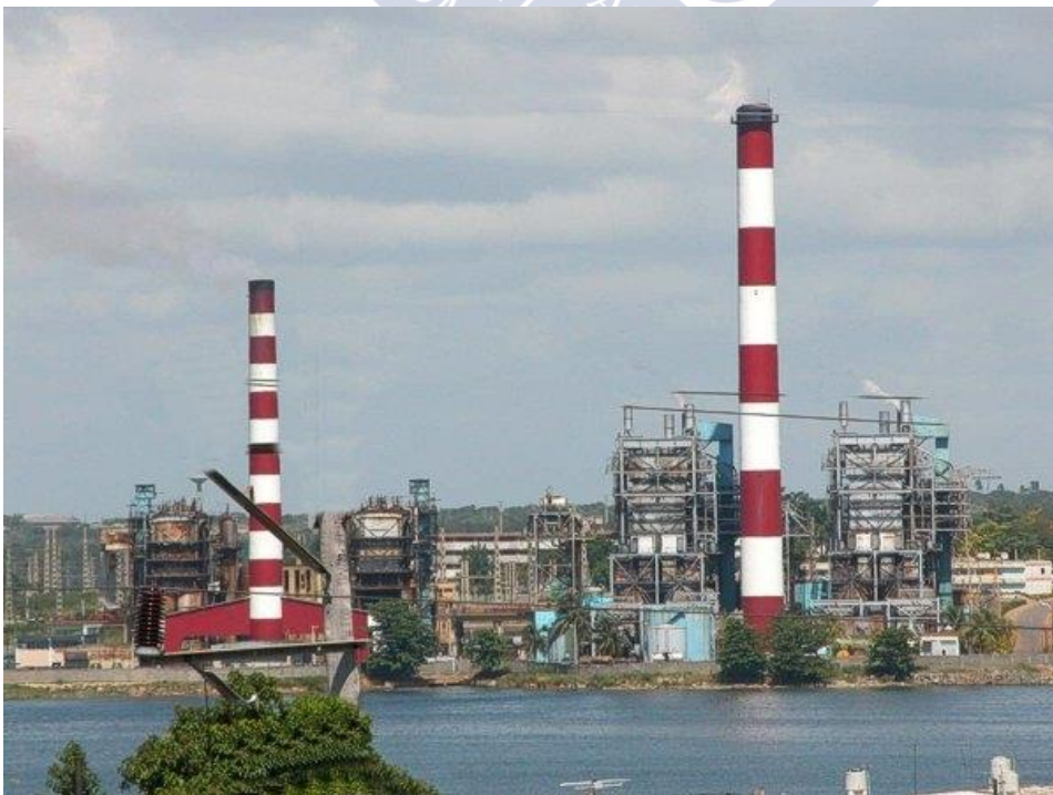
Figura 9.7 Vista general de la termoeléctrica “Carlos Manuel de Céspedes”.
