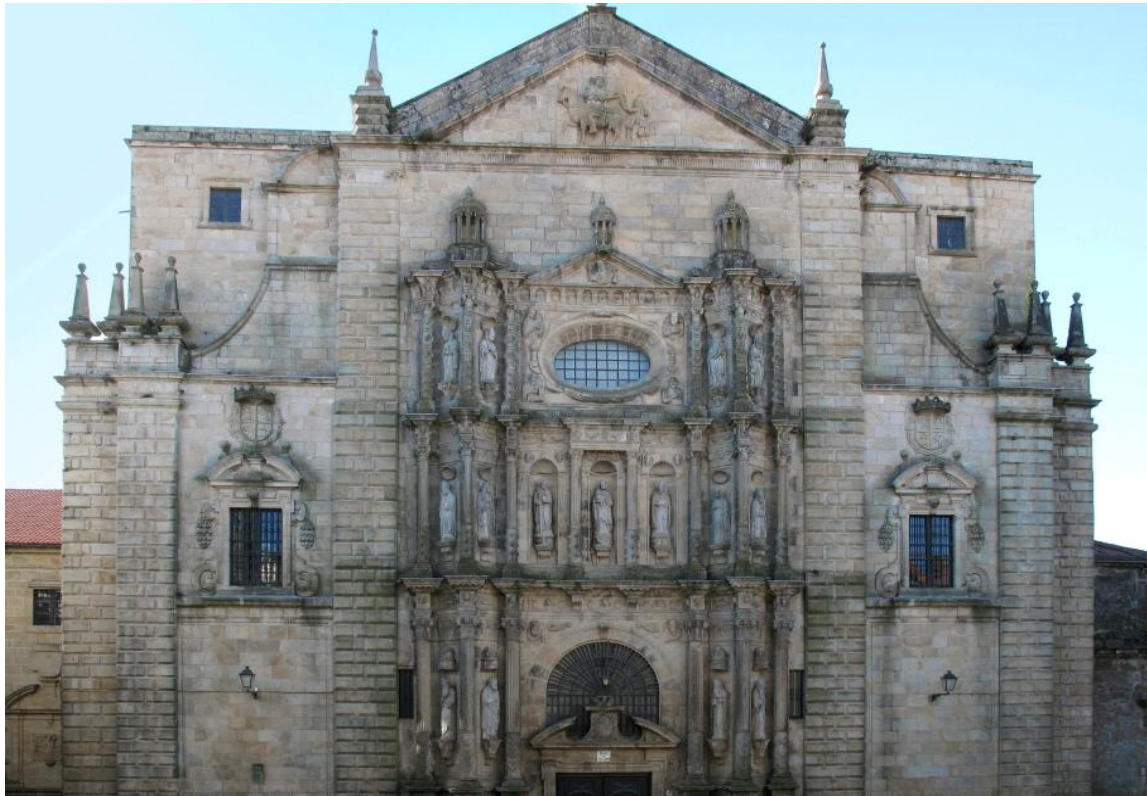
Figura 87: Fachada de la iglesia de San Martiño Pinarío.
