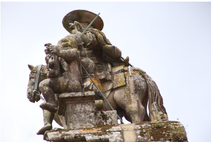
Figura 28: Remate de la fachada principal con grapas y sujeciones.
