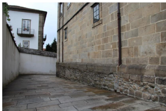
Figura 40: Tramo superior de la travesía de Dúas Portas. Se observan los cimientos debido al cambio de rasante.
