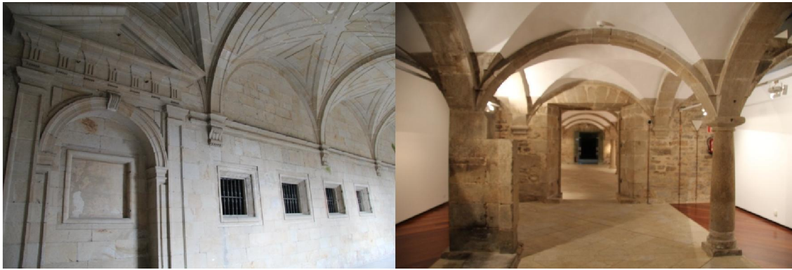
Figura 57: Galería baja del claustro Procesional. Vanos para la iluminación de la capilla de San Felipe Neri (Antigua sala del Capítulo y sacristía). Figura 58: Tullas.
