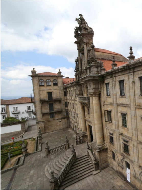
Figura 26: Fachada de San Martiño vista desde la torre este.
