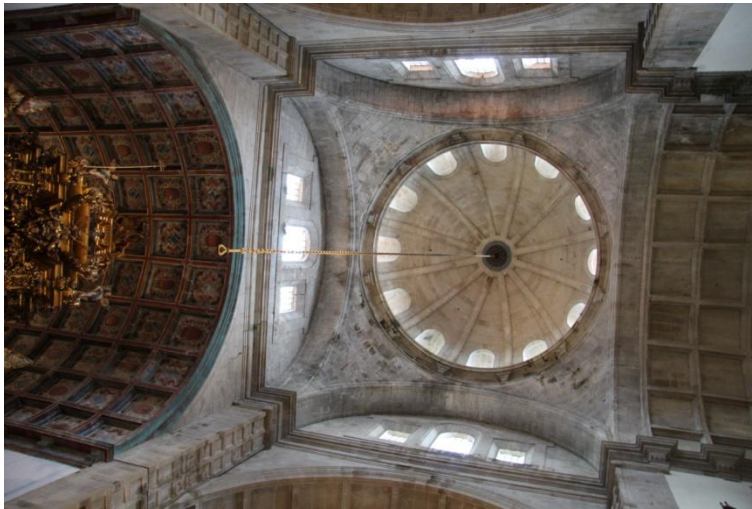
Figura 92: Cúpula del crucero de San Martiño.
