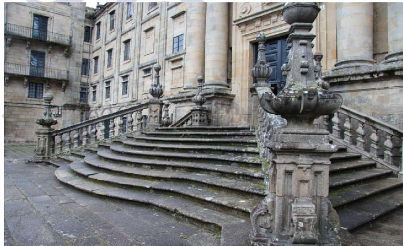
Figura 27: Escalera de acceso a San Martiño.
