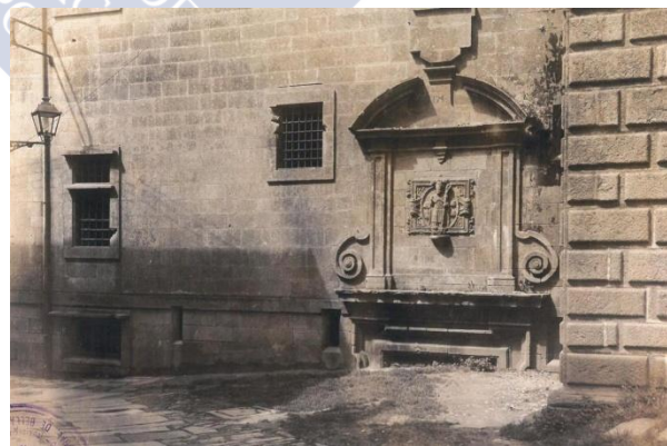
Figura 36: Puerta noroeste de acceso al claustro Procesional y tullas . Oculta parcialmente por escombros, 1948. A.G.A. Cultura, 5, 51/11274, en Castro Fernández, 2013: 154.
