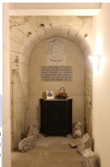
Figura 65: Arco de conexión entre el torreón este y la zona central de la fachada en la planta baja.
