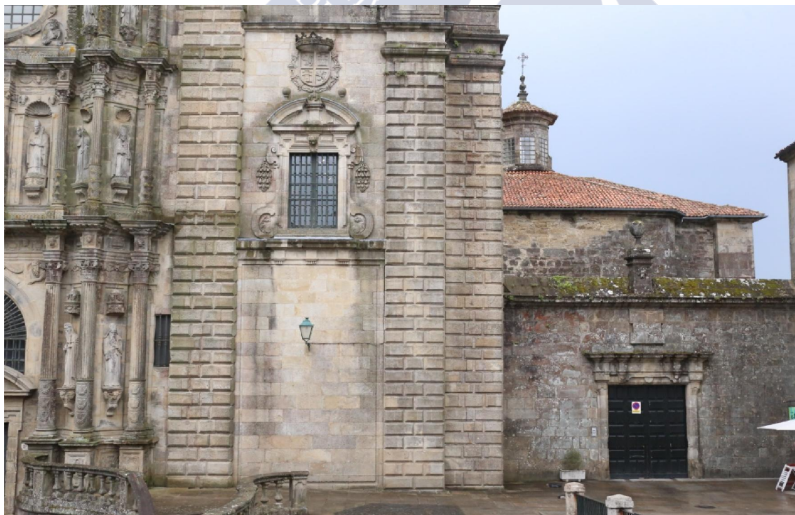
Figura 88: Arranque de la torre norte de la iglesia y puerta de acceso a la huerta.
