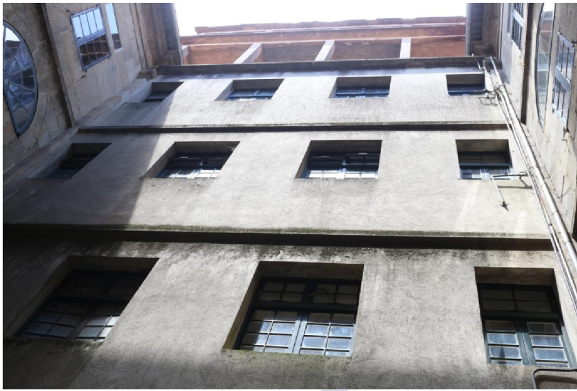
Figura 84: Pabellón para sanitarios construido en el patio Pequeño.
