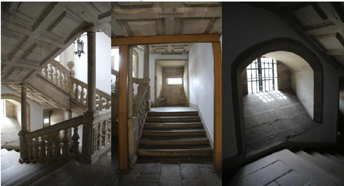
Figuras 59, 60 y 61: Escalera de Cámara. Sujeciones y refuerzos instalados a posteriori a base de columnas, vigas y rellenos de los huecos de las ventanas.
