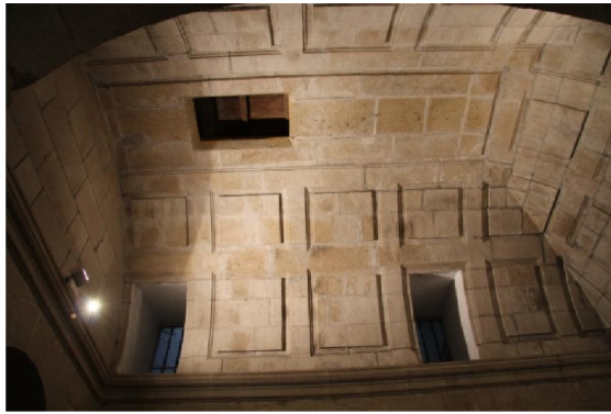
Figura 104: Vanos de conexión con la escalera del Refectorio. Capilla de San Felipe Neri.
