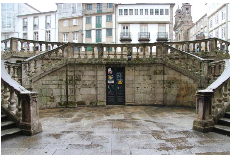
Figura 91: Escalera de acceso a la iglesia y puerta de transformador eléctrico.
