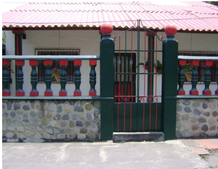
Figura 91. Edificación en población de Utica con muros a media altura en canto rodado y refuerzo en acceso principal. Fuente: Elaboración propia.
