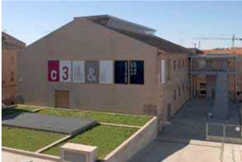
Imagen 45. Exterior Centre d'Art La Panera. Lleida
