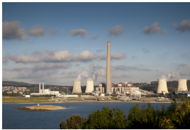
Figura 6.1: Vista de la central térmica de As Pontes
