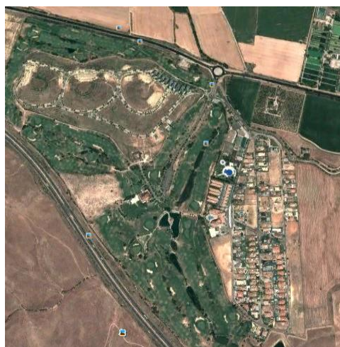
Figura 32 – Vista aérea do campo de golfe, "Guadiana Golf". (Fonte:www.googleearth.com).
