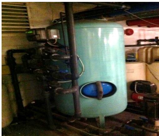
Figura 4. 2 - Depósito de água do sistema de tratamento antigo.
