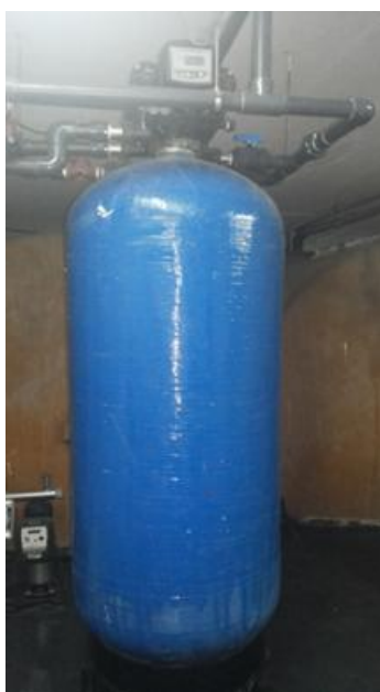
Figura 3. 8 - Filtro de impurezas.
