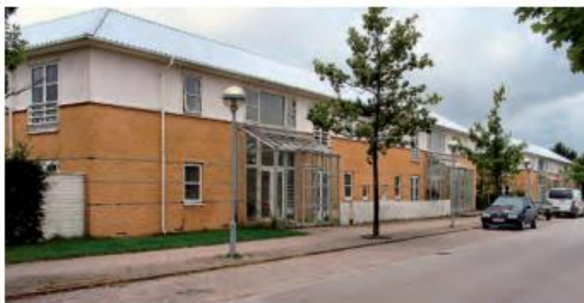
Figura 2.12 - Skotteparken Egebjerggard em Ballerup (NHBC Foundation, 2009).
