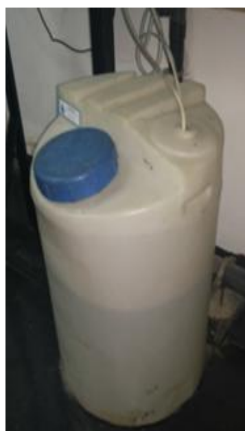
Figura 3. 9 - Reservatório de tratamento de água.
