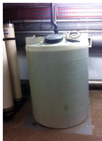
Figura 4. 5 - Depósito onde a água é tratada.
