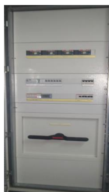
Figura 3. 14 - Quadro geral de todos os pisos.
