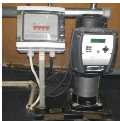
Figura 3. 4 - Central hidropneumática.
