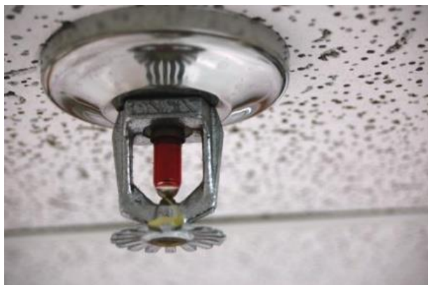
Figura 4. 8 – Sprinklers (BUCKA, 2013).
