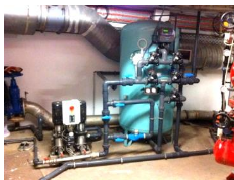
Figura 4. 5 - Depósito onde a água é tratada.
