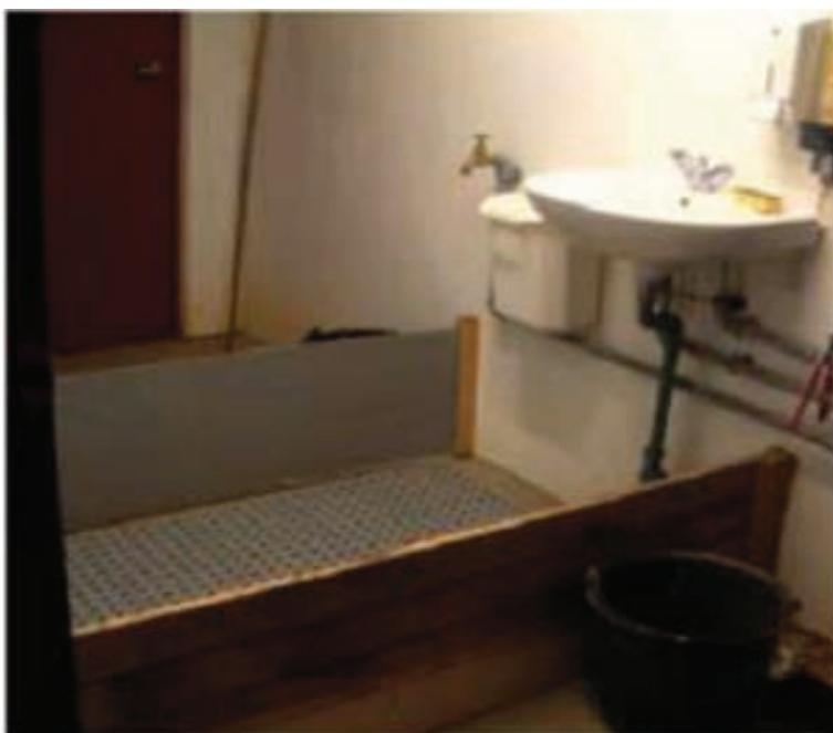
**Figura 4** - Barreira física na antecâmara de um pavilhão (Adaptado de: FSAI, 2011).
