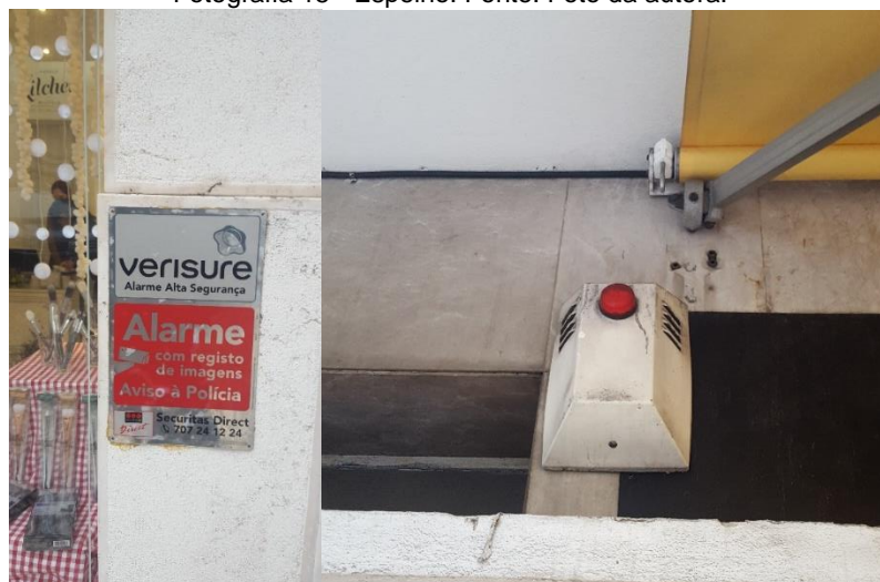
Fotografia 16 - Alarme. Fonte: Foto da autora.
