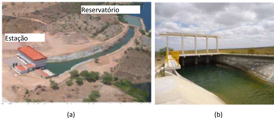
Figura 2: (a) - Reservatório de Apolônio Sales e Estação Elevatória; (b) início do canal - km zero(0).
