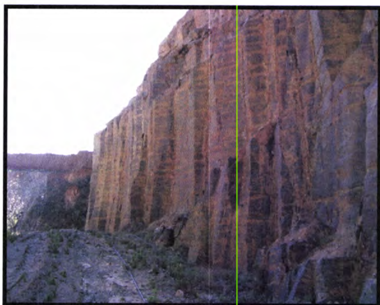
Fig. 1- Aspecto geral da pedreira de Portela apresentando disjunção colunar
