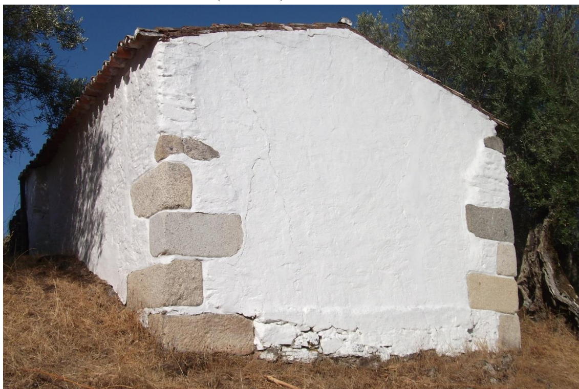
Figura LXII – Silhares reutilizados na construção da ermida de Santo Estevão.
