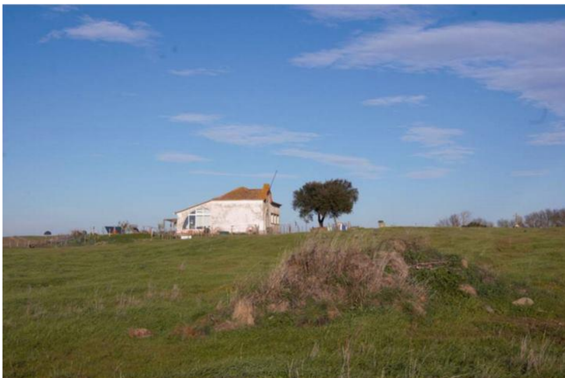
Figura VII – Vista geral de Santa Justa 3.
