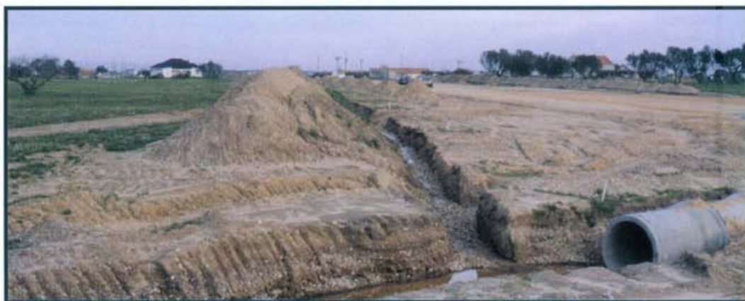
Figura 13 - Exemplo da vala de sondagem extensiva, aberta na superfície prospectada.
