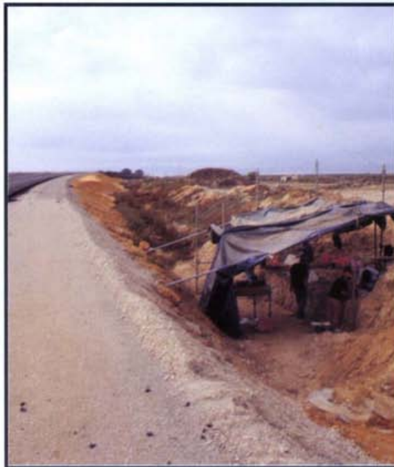
Figura 15 - Aspecto geral dos trabalhos de escavação.
