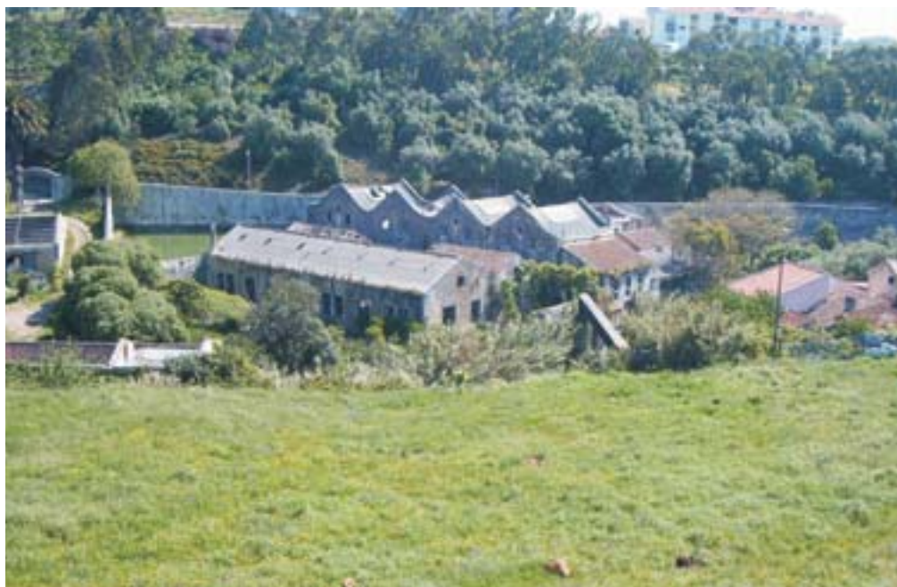
Fig. 15 – Panorâmica da núcleo antigo da Fábrica de Cima, sendo facilmente identificável o conjunto de quatro oficinas que alojaram os engenhos de galgas. Os dois espaços, à esquerda na foto, correspondem ao espaço anteriormente ocupado pelas Ferrarias del Rey .
