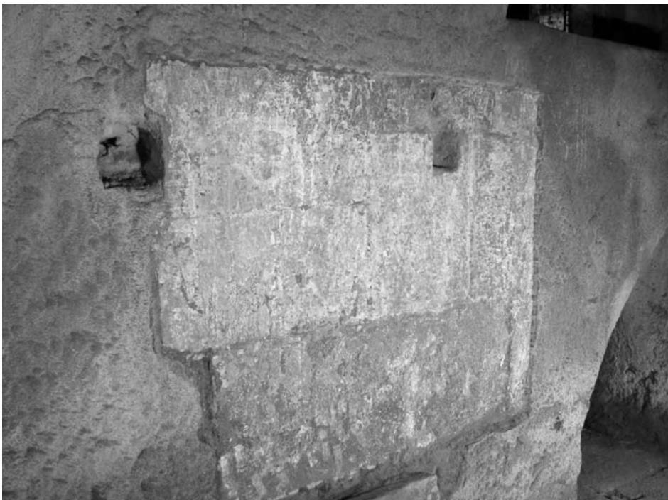
Fig. 11 – Pormenor da estrutura de apoio do eixo do engenho de verrumar, situado no vão do 3º arco.
