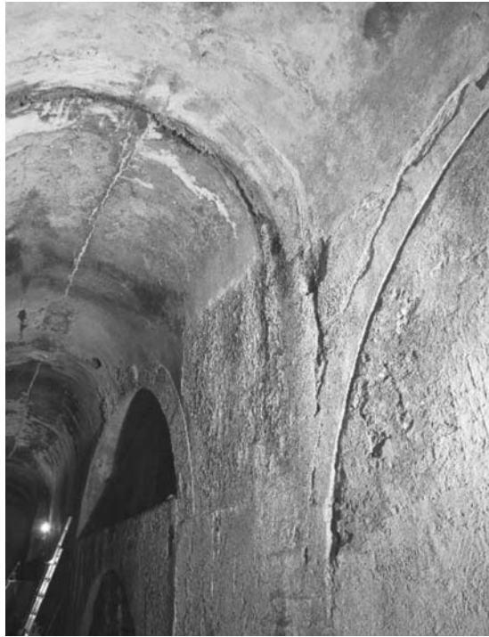
Fig. 10 – Junção do troço de galeria correspondente às antigas “Ferrarias” com a ampliação executada aquando da instalação de uma segunda Fábrica da Pólvora. Embora não sendo observável, notada uma ligeira inflexão na orientação do novo troço da galeria, face ao já existente.
