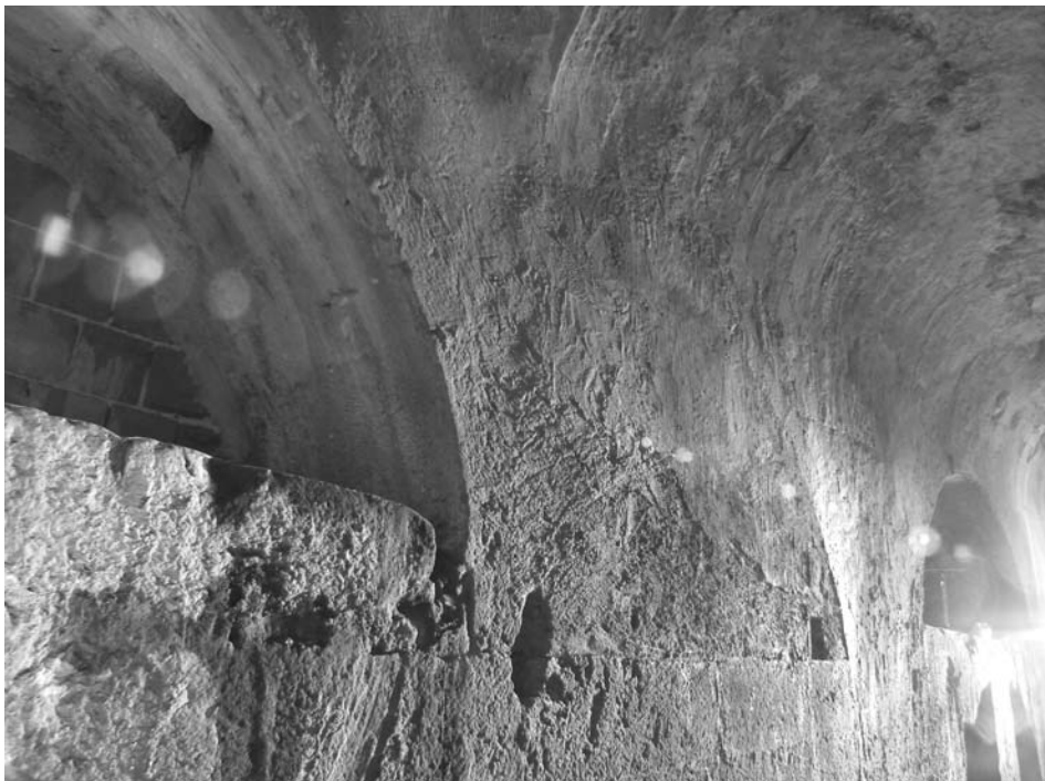
Fig. 3 – A técnica de projecção de “luz rasante” permitiu visualizar indícios da presença das cantarias dos arcos que se encontrava ocultas sob as camadas de concreções e das argamassas de reboco. Foram utilizados 4 projectores de halógeno de 500 W.
