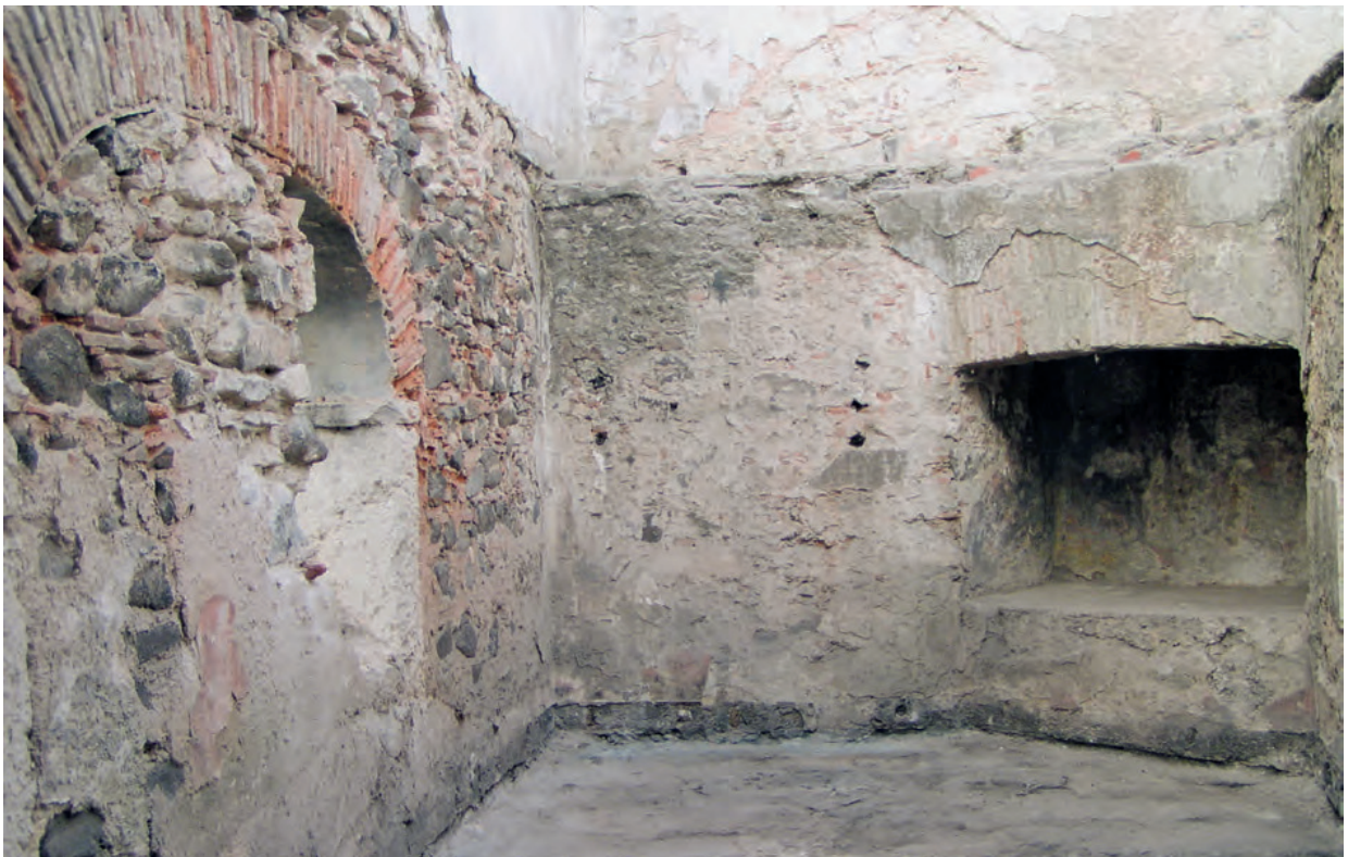
Fig. 10 – Ferrarias del Rey . Vista parcial do Edifício 49-T, depois de desobstruído de entulhos, observando-se o revestimento original lajeado do piso térreo e um fogão, ao fundo, compatível com a sua atribuição à “Casa do Superintendente”, comunicando com dependência adjacente (Edifício 32-G) através de grande arco, ulteriormente fechado.
