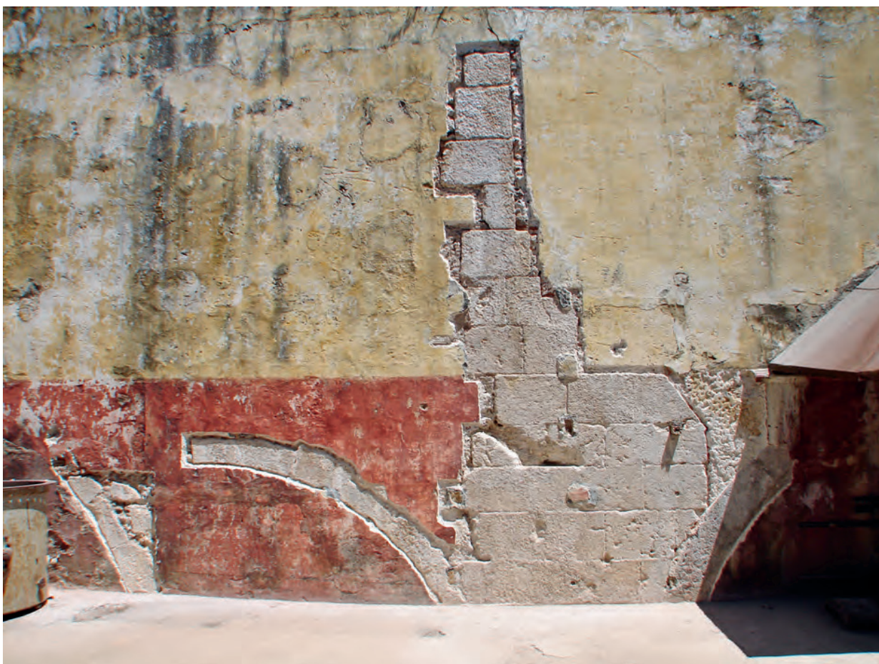
Fig. 3 – Ferrarias del Rey . Picagem de rebocos na parede externa do lado ocidental do edifício, realizada em 2007, identificando-se o cunhal de alvenaria aparelhada correspondente ao limite do edifício anteriormente ao acrescento realizado no final do século XVIII sob a égide de Bartolomeu da Costa.
