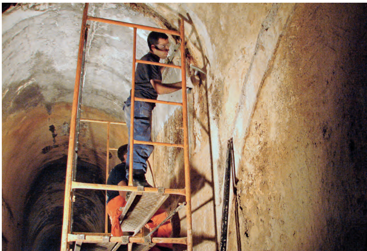
Fig. 2 – Ferrarias del Rey . Limpeza da parede da galeria dos engenhos de concreções e sedimentos, em 2007, com o objectivo de identificar elementos estruturais de distintas épocas de construção.
